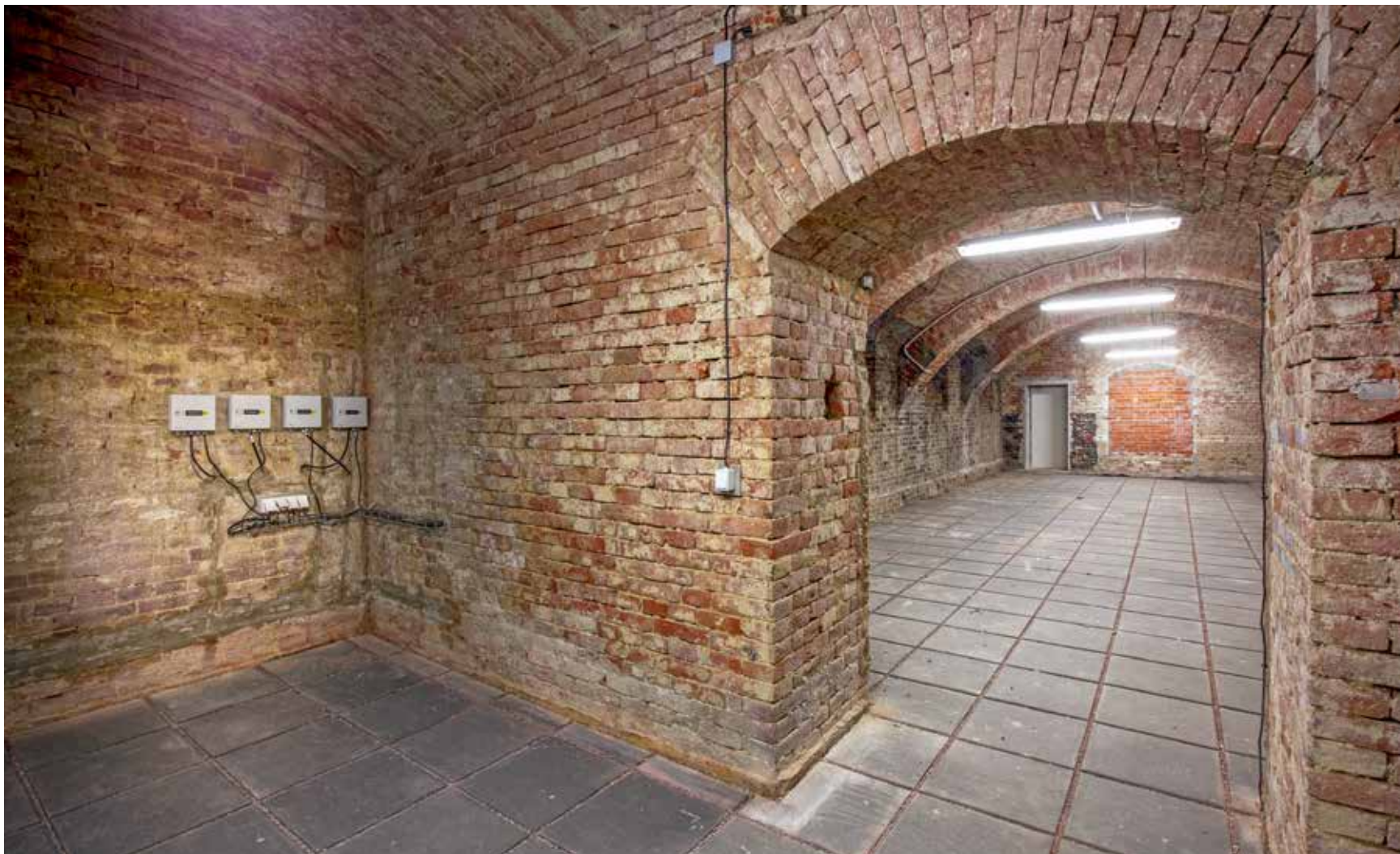
Sklepní prostory po rekonstrukci
