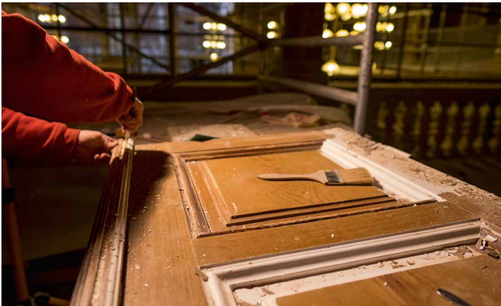
Rekonstrukce historických interiérů
