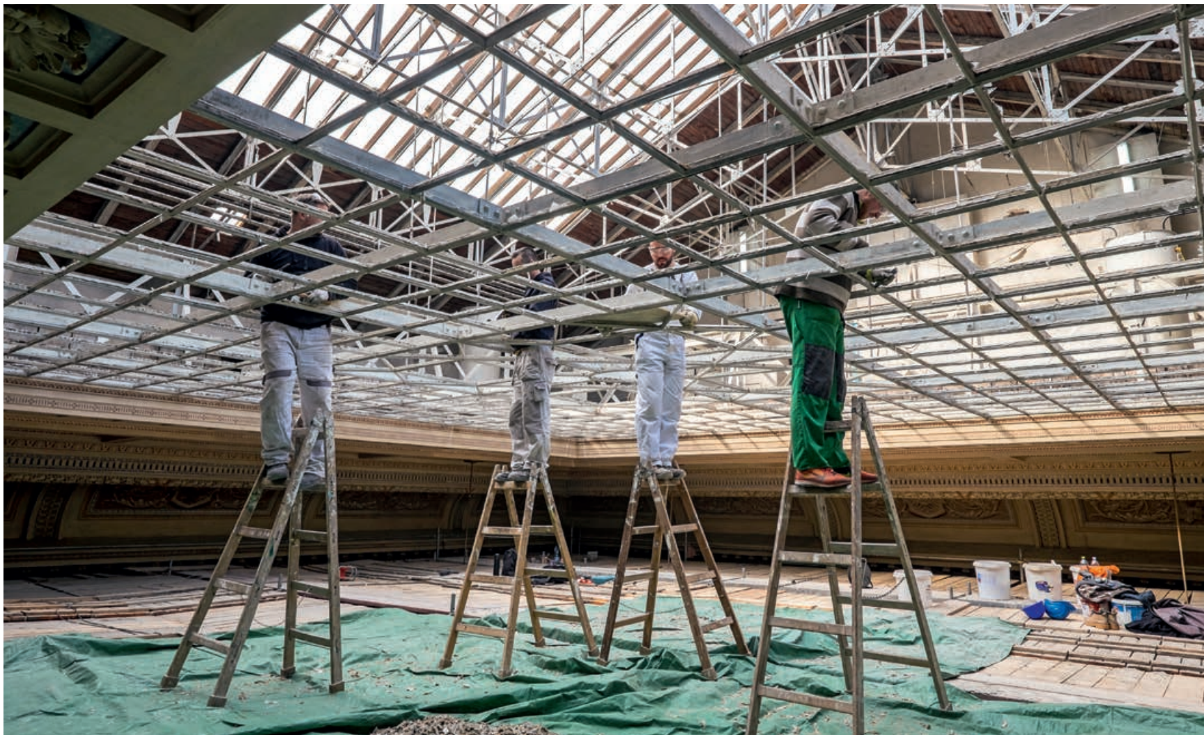
Opravy kovové konstrukce světlíku
