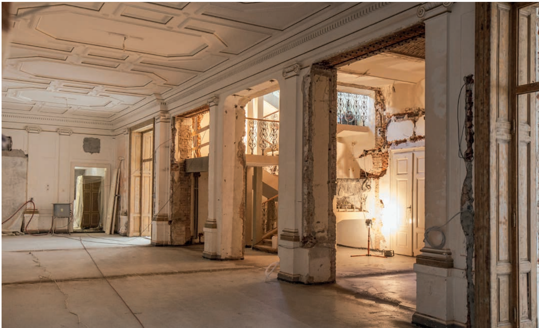
Předsálí sněmovny v průběhu stavebních prací
