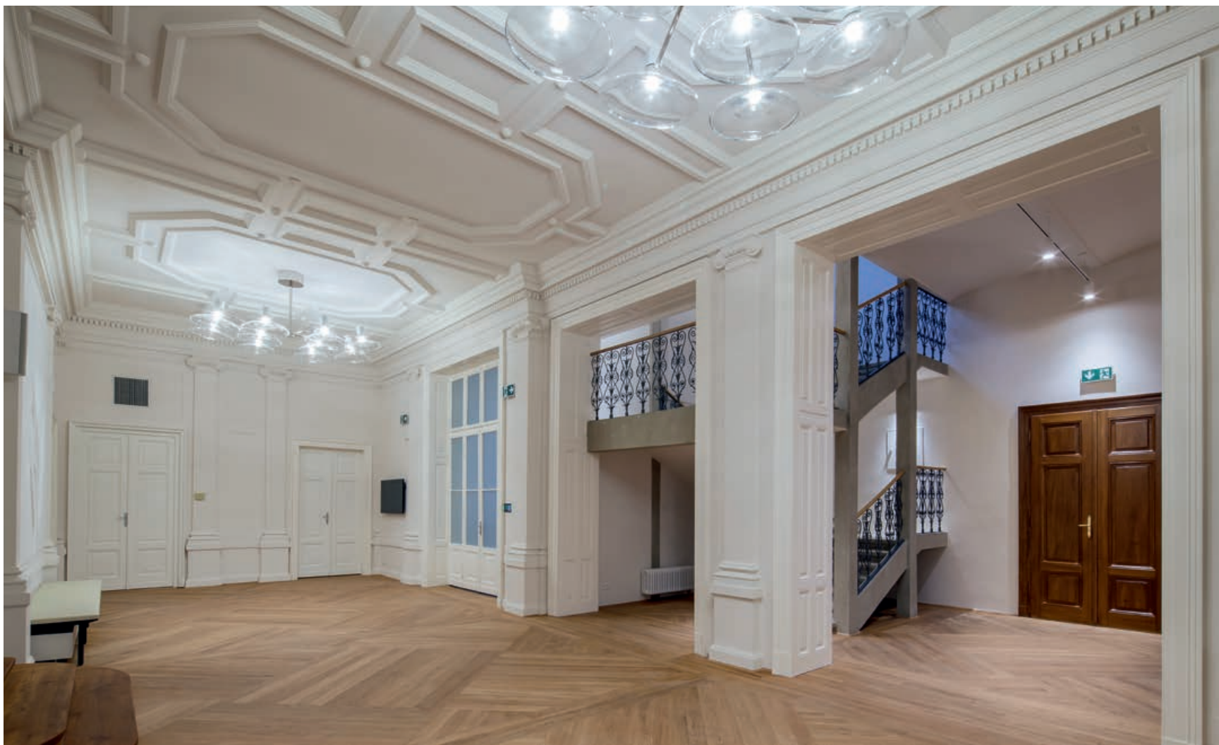
Předsálí sněmovny po rekonstrukci
