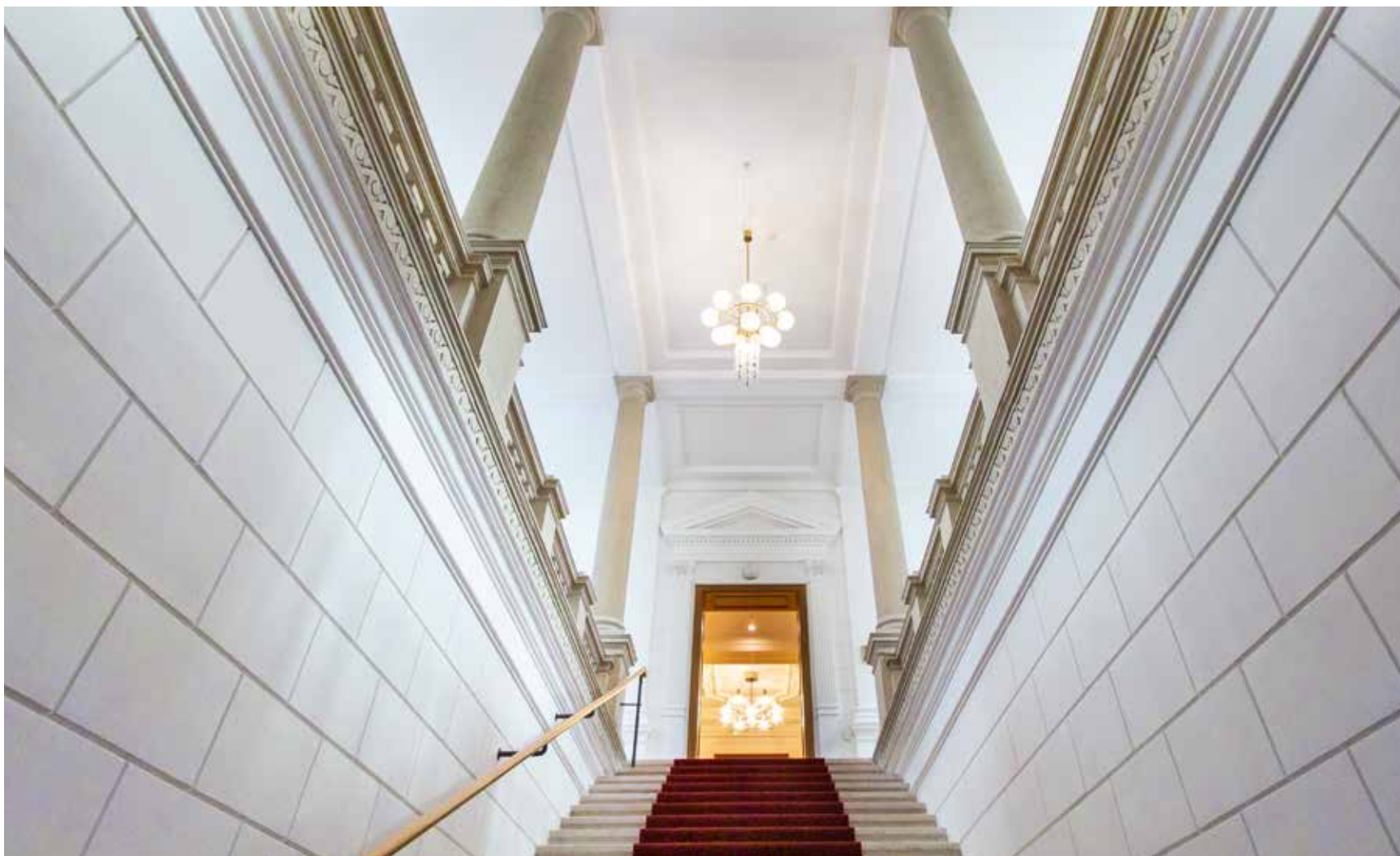
Na stávajících schodištích byla doplněna chybějící madla
