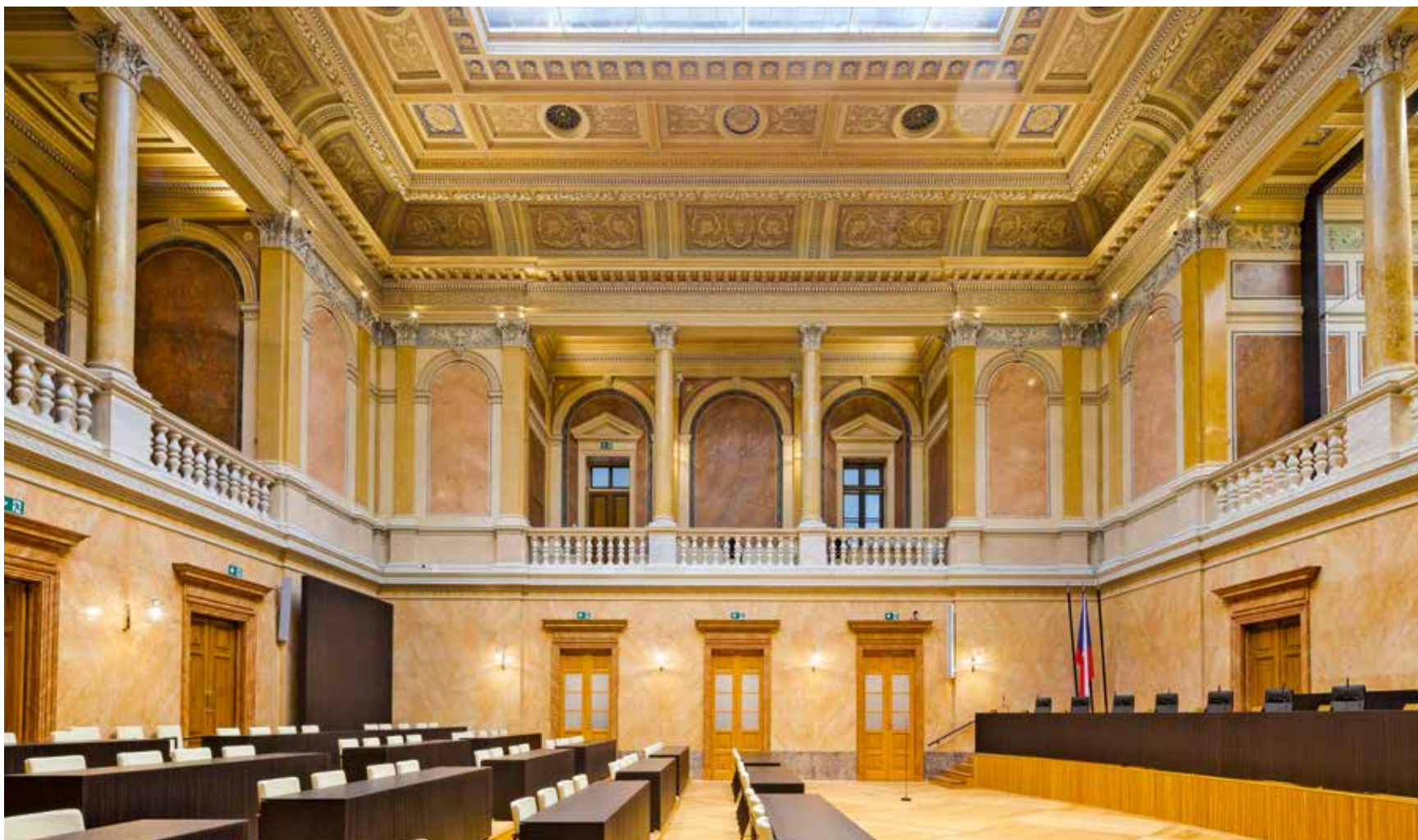
Odstranění bariér ve sněmovním sále, který byl původně řešen stupňovitě. Při rekonstrukci byla stupňovitost částečně odstraněna a v první řadě byla vytvořena místa pro pohybově handicapované osoby
