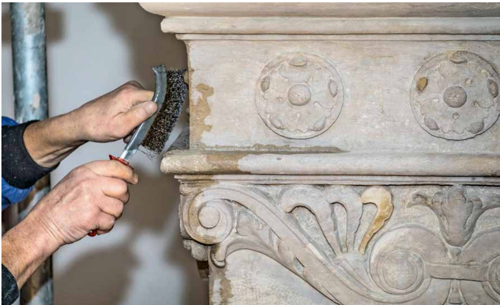
Průběh rekonstrukčních a restaurátorských prací ve stávajícím schodišťovém prostoru
