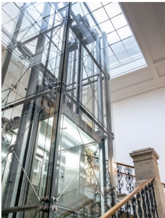
Nově vytvořený výtah v severním schodišti, který vznikl při rekonstrukci schodiště v roce 2021
