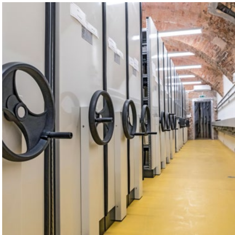
Výtah propojuje všechna podlaží v budově; díky tomu se podařilo bezbariérově zpřístupnit i nově vybudované spisovny
